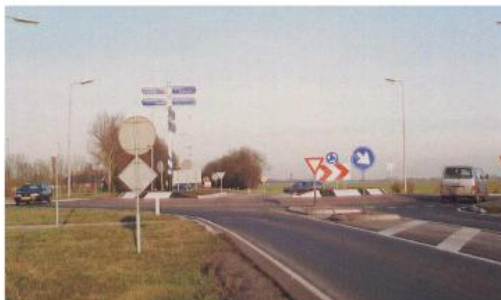
Roundabout N216 / Peppelweg-Melkweg Giessenlanden Zuid-Holland, The Netherlands
